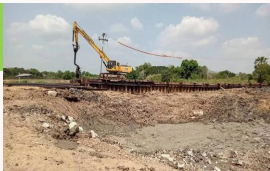
กิจกรรมงานป้องกันการพังทลายของดิน ข้างบ่อก่อสร้าง
