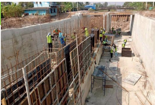
กิจกรรมก่อสร้างอาคารสถานีสูบน้ำ
