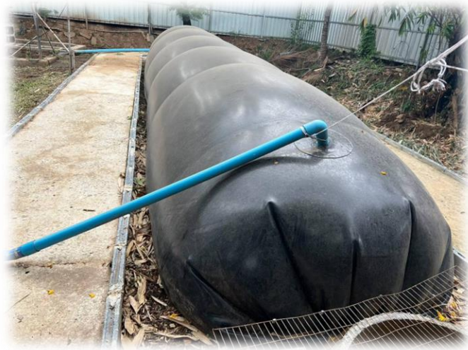
ภาพที่ 3.10 การจัดการมูลแบบบ่อหมักไร้อากาศ (anaerobic digester)
