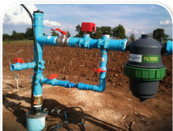
ภาพที่ 43 การติดตั้งกรองเกสรแบบแผ่น และใ้กรองแบบแผ่นสีแดงความละเอียด 120 Mesh
