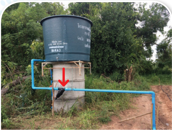
ภาพที่ 44 การติดตั้งกรองเกษตรกับระบบสวนดริ้งน้ำหยด
