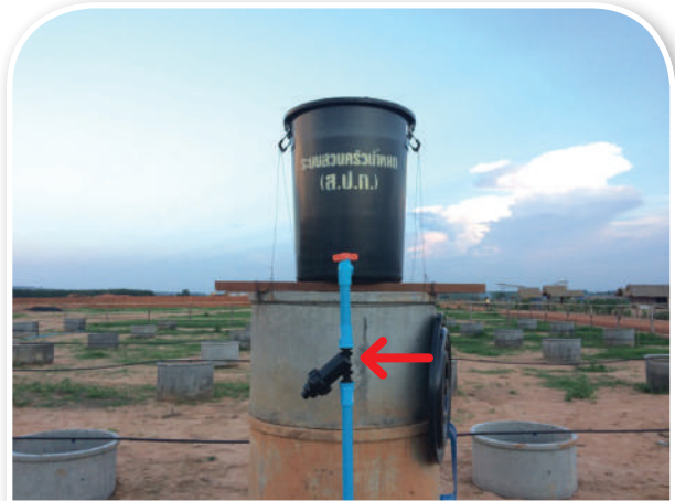
ภาพที่ 44 การติดตั้งกรองเกษตรกับระบบสวนดริ้งน้ำหยด
