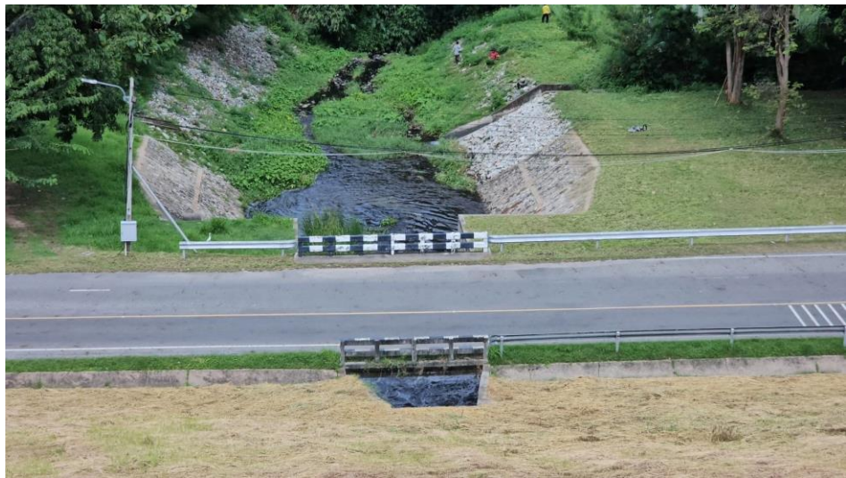
ภาพ การระบายน้ำผ่านประตูระบายน้ำฉุกเฉิน(river outlet)และทางระบายน้ำล้น(spillway)
