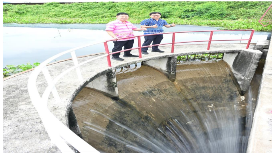
ภาพ การระบายน้ำผ่านประตูระบายน้ำฉุกเฉิน(river outlet)และทางระบายน้ำล้น(spillway)
