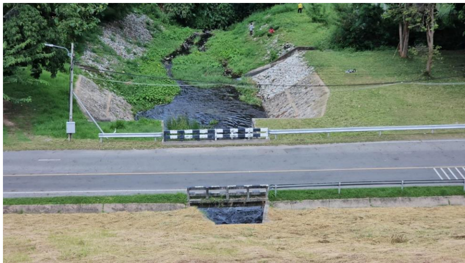
ภาพ การระบายน้ำผ่านประตูระบายน้ำอุกเขิน(river outlet)และอาคารระบายน้ำล้น(spillway)
