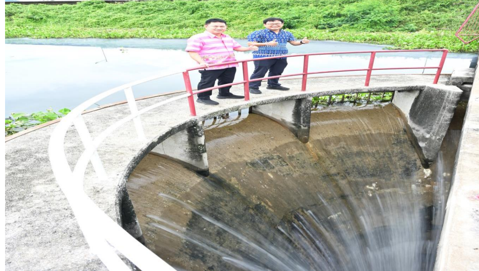
ภาพ การระบายน้ำผ่านประตูระบายน้ำอุกเขื่อน(river outlet)และอาคารระบายน้ำล้น(spillway)
