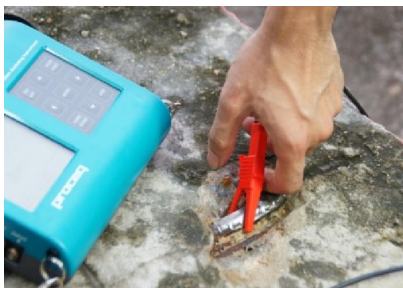
รูปที่ 8 การเจาะสกัดผิวคอนกรีตให้สามารถเชื่อมต่อกับเครื่องทดสอบได้
