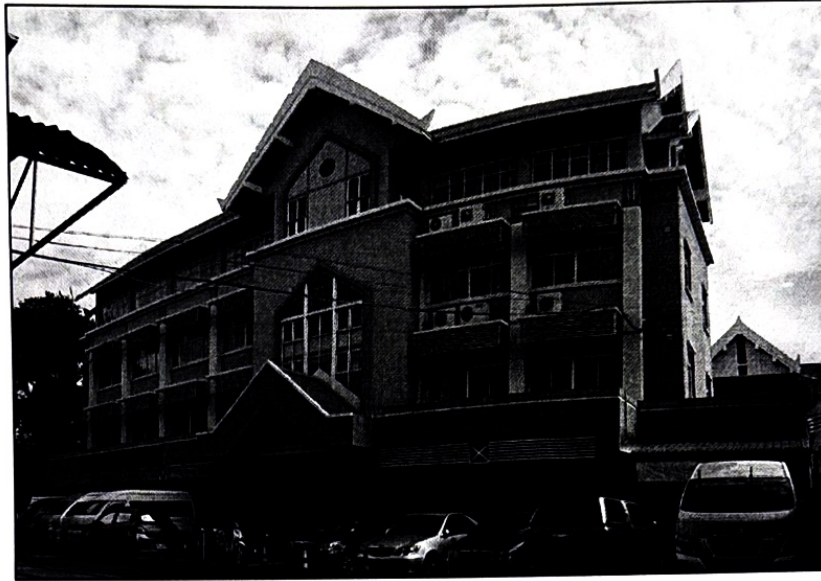
หลังลำดับที่ ๑๘ อาคาร ค.ส.ล. ๔ ชั้น (อาคารกองคลัง) (อาคาร ๕)
