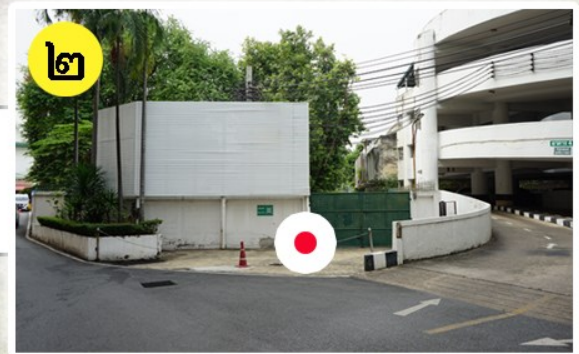
จุดที่ ๒ บริเวณทางขึ้นลานจอดรถยนต์ อาคาร ๔ (ด้านหลังอาคาร ๑)
