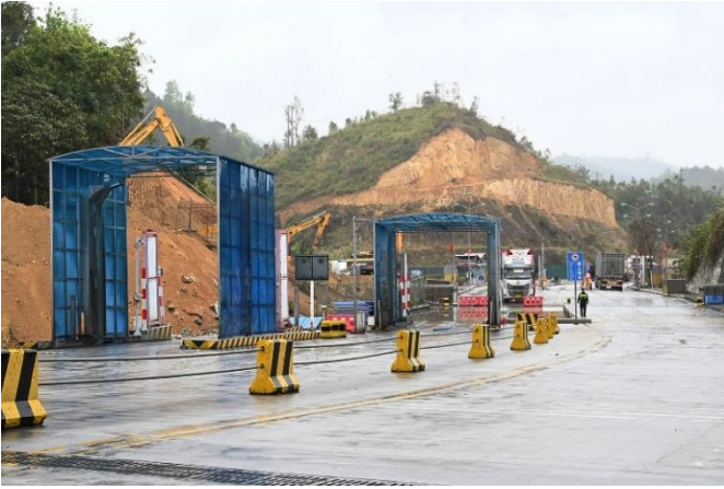
ช่องทางเดินรถบรรทุกเข้า-ออกระหว่างจีนและเวียดนาม 4 ช่องจราจร (เข้า 2 ออก 2) และอยู่ระหว่างการปรับปรุง พื้นที่ด้านซ้ายมือเพื่อขยายช่องจราจรเพิ่มอีก 2 ช่อง
