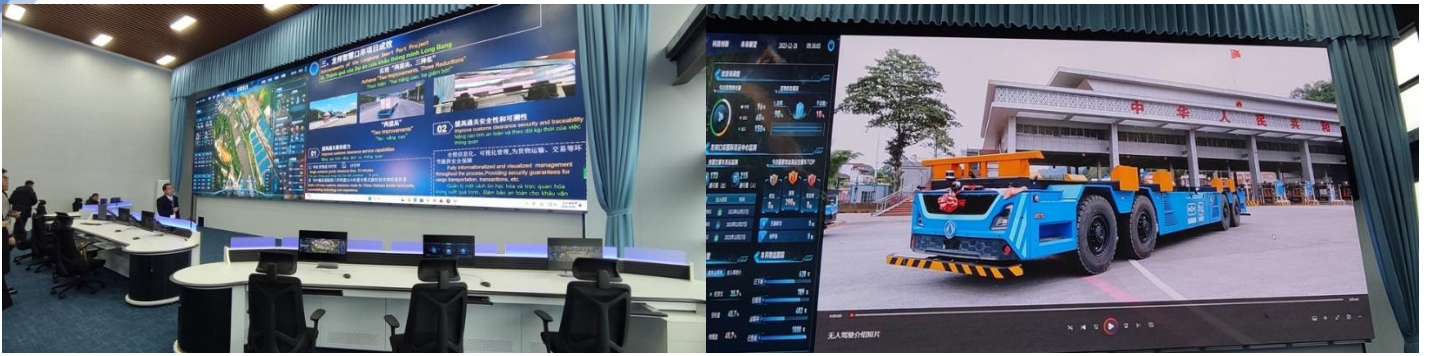
ห้องระบบควบคุมของด่านหลังปิง
