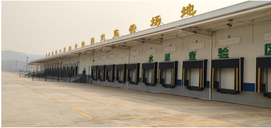
สถานที่ควบคุมตรวจสอบจำเพาะสำหรับผลไม้ ธัญพืช และสินค้าสัตว์น้ำแช่เย็นนำเข้าที่ด่านรถไฟพรมแดน
