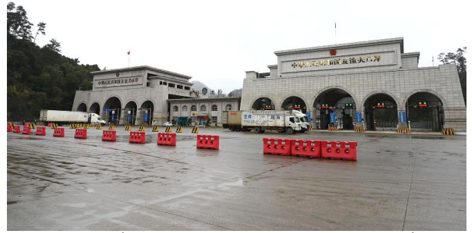
ด่านโหย่วอี๋กวน มี 2 อาคาร แต่ละอาคาร มี 6 ช่องไม้กั้น รองรับการเข้า-ออกของรถบรรทุก 6 คัน (3 เข้า 3 ออก) โดยอาคาร 2 (ขวามือ) อยู่ระหว่างการตรวจรับ จากหน่วยงานระดับชาติ
