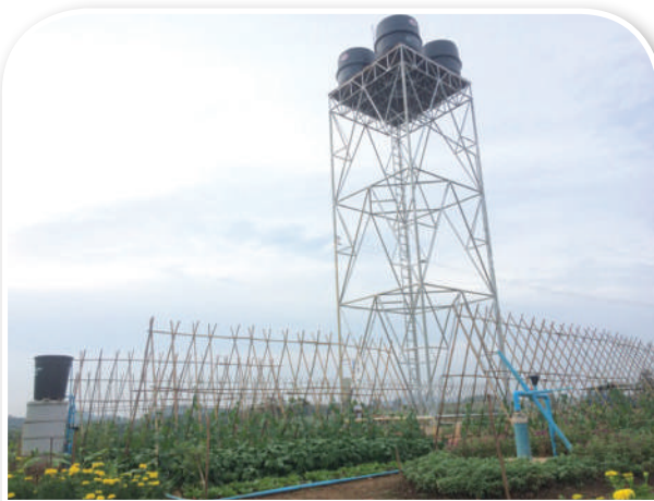
ภาพที่ 33 หอดักสูงที่ใช้กับระบบน้ำหยด
