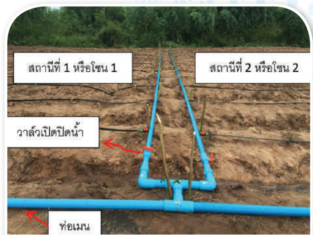
ภาพที่ 65 ตัวอย่างการแบ่งสถานีจ่ายน้ำในแต่ละโซนของพื้นที่ให้น้ำ
