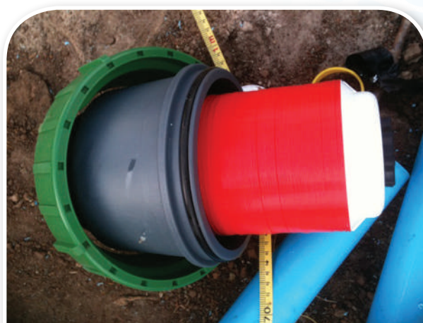
ภาพที่ 43 การติดตั้งกรองเกสรแบบแผ่น และใ้กรองแบบแผ่นสีแดงความละเอียด 120 Mesh
