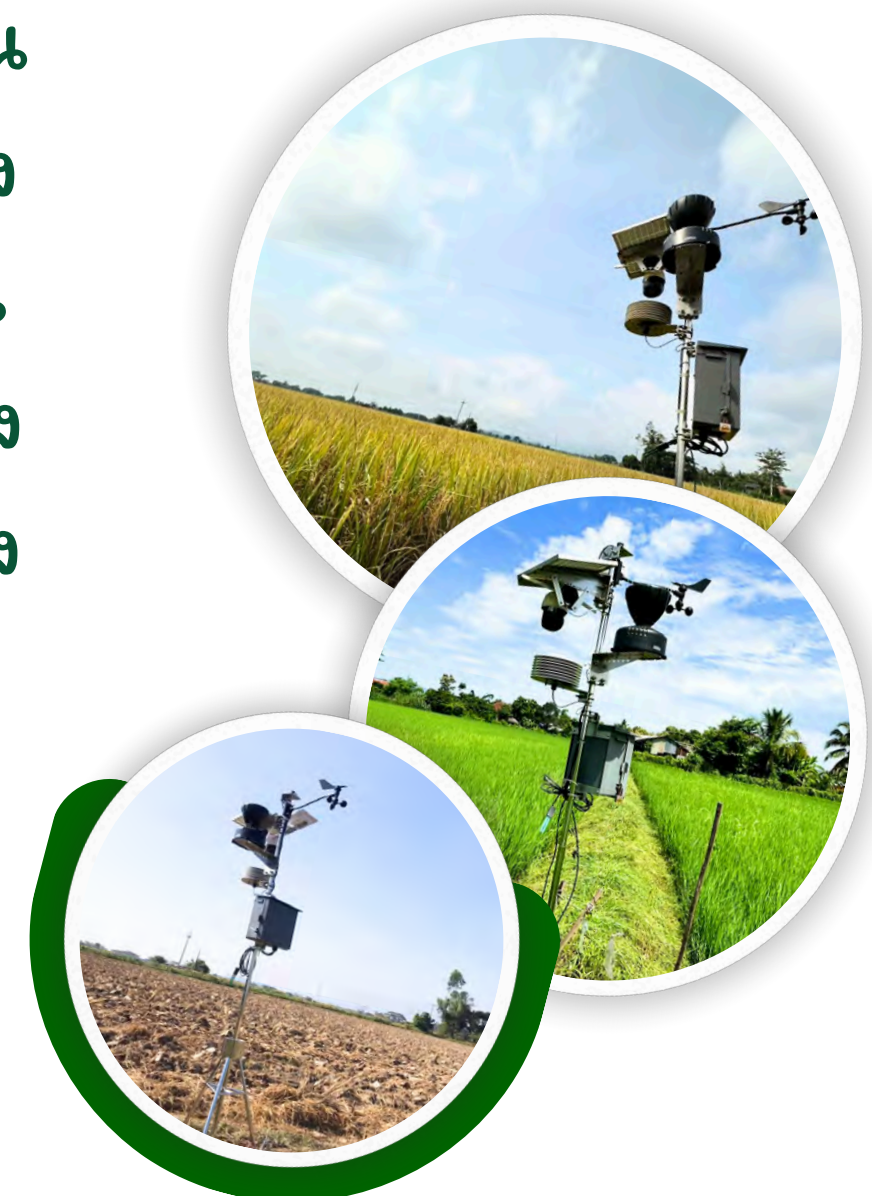
ภาพที่ 12 การติดตั้งสถานีตรวจอากาศอัตโนมัติ บริเวณพื้นที่แปลงนา
