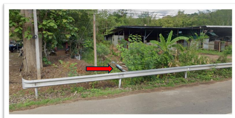
แนวท่อส่งน้ำ (บริเวณ อยู่ ต.เต๋อยนต์)
