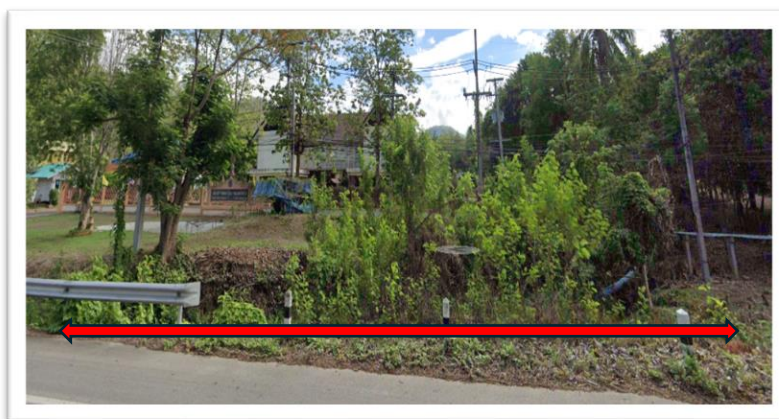
แนวท่อส่งน้ำ (บริเวณแขวงทางหลวงชนบทแม่ฮ่องสอน)
