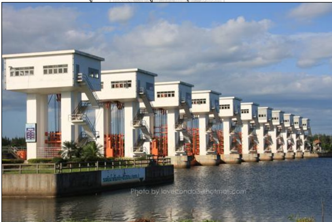
รูปที่ 53 ประตูระบายน้ำอุทกวิภาชประสิทธิ์
