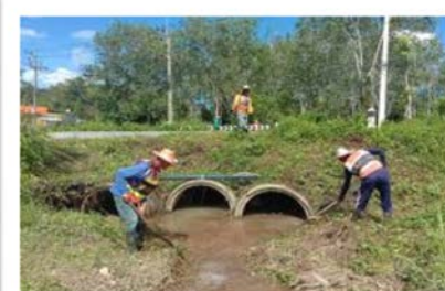
ทำทางระบายน้ำ
