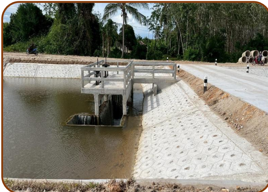
รูปภาพ ๓ ( ภาพอาคารบังคับน้ำคลองระบายน้ำ D๑-๔.๕L แล้วเสร็จ )
