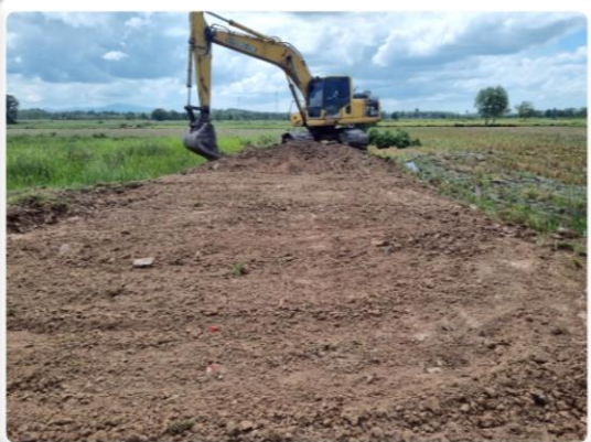
๕.๓ งานขุดเปิดหน้าดินด้วยเครื่องจักร
