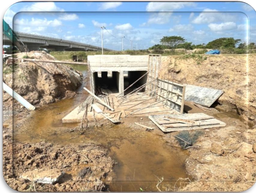
รูปภาพ ๒ ( ภาพวางแผนเพื่อเทคอนกรีตโครงสร้าง )
