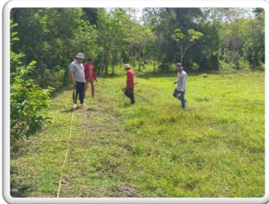
๕.๑ เจ้าหน้าที่เข้าตรวจสอบพื้นที่ ก่อนดำเนินการก่อสร้าง
