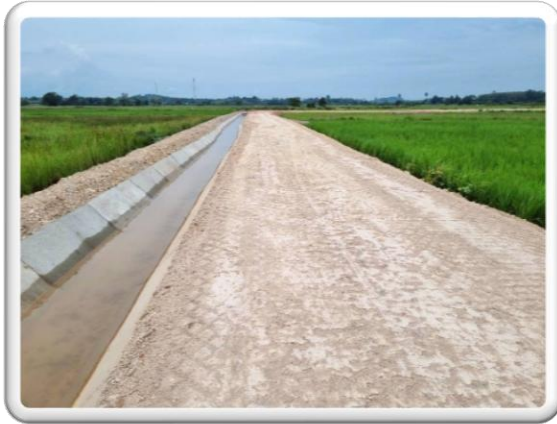
๕.๗ งานคูส่งน้ำตาดคอนกรีตแล้วเสร็จ
