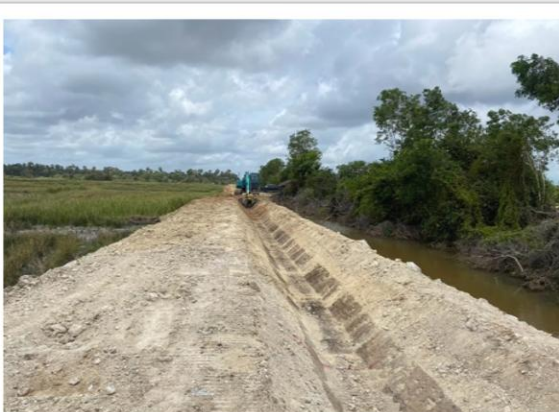
๕.๕ งานขุดดินด้วยเครื่องจักร
