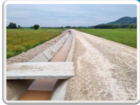
๕.๘ งานคูส่งน้ำตาดคอนกรีตแล้วเสร็จ
