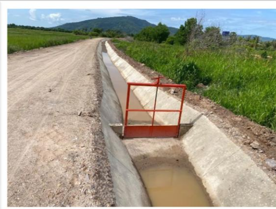
๕.๖ งานคูส่งน้ำตาดคอนกรีต
