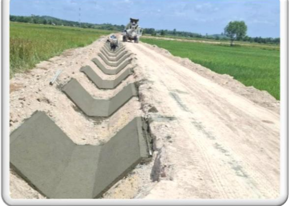
๕.๖ งานคูส่งน้ำตาดคอนกรีต
