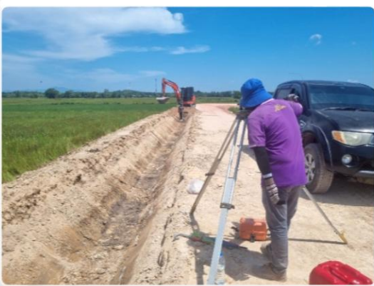
๕.๕ งานขุดดินด้วยเครื่องจักร
