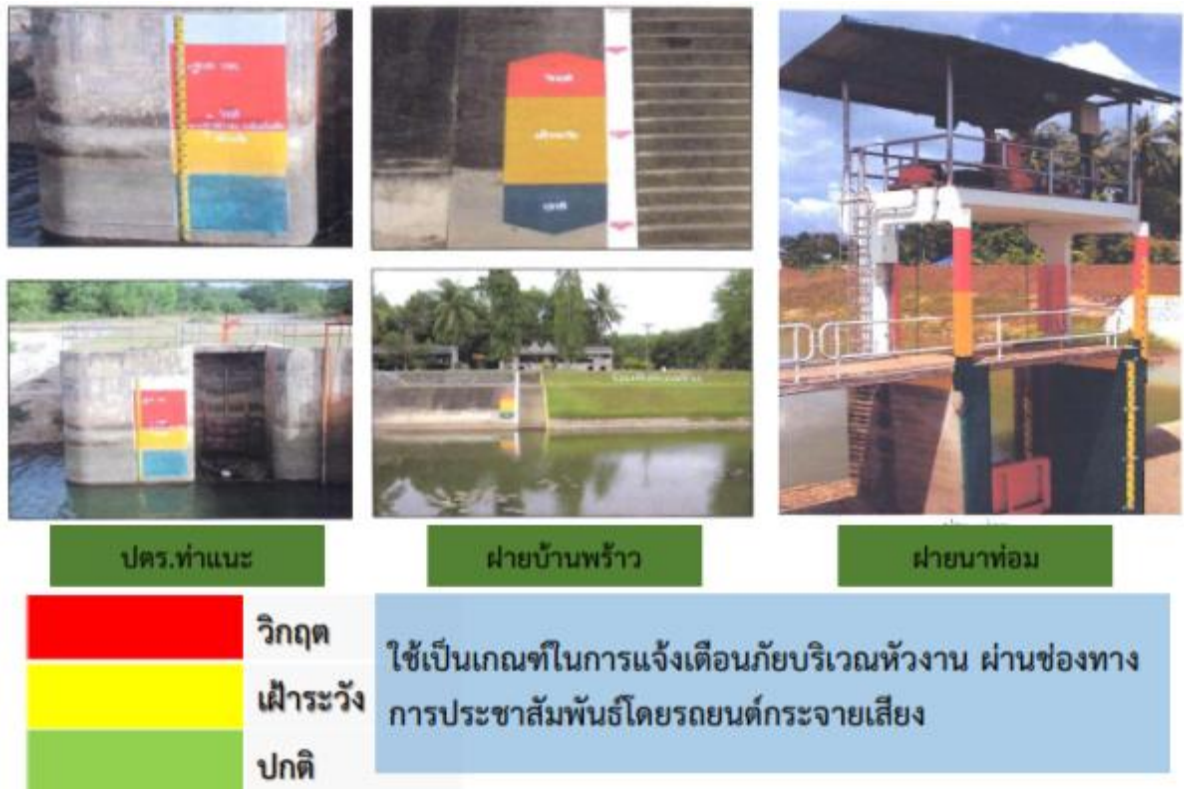
รูปที่ ๒๔-๒๖ ระบบการแจ้งเตือน โดยใช้ระดับน้ำและเวลาเคลื่อนตัวของน้ำในคลองลำ - คลองนุ้ย
