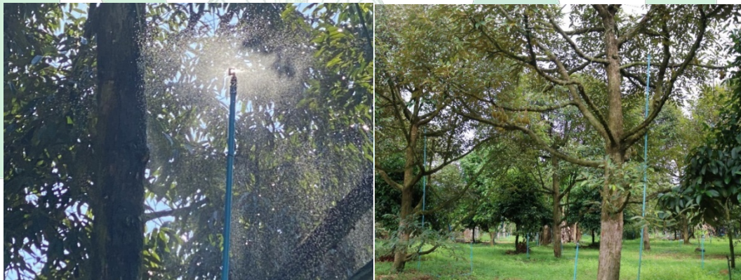
รูปภาพ : ติดตั้งท่อสปริงเกอร์ เพิ่มพ่นน้ำบนทรงพุ่มให้แก่ต้นทุเรียน
