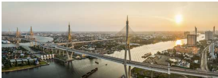
สะพานภูมิพล 1 สะพานภูมิพล 2
