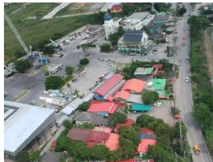
แยก ทล.หมายเลข 2244 (กม.ที่ 15.568) - บ้านบางพลีใหญ่
