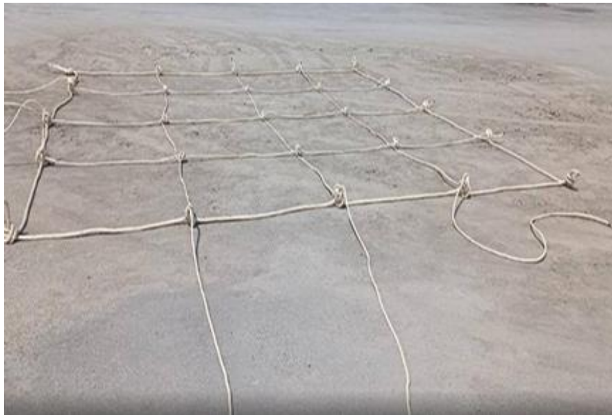
ภาพที่ 14 การถักเชือกเป็นช่องตารางของแพ
