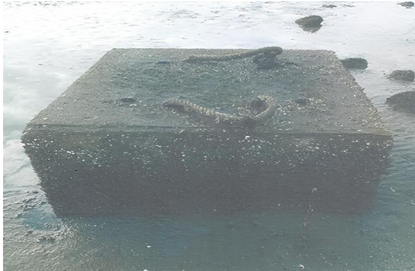
ภาพที่ 19 ทุ่นสมอคอนกรีต ขนาด 1 \times 1 \times 0.6 เมตร
