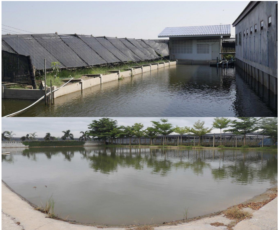
ภาพที่ 27 บ่อพักน้ำแปลงกล้วยไม้
