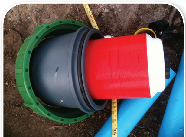
ภาพที่ 43 การติดตั้งกรองเกษตรแบบแผ่น และไล้กรองแบบแผ่นสีแดงความละเอียด 120 Mesh
