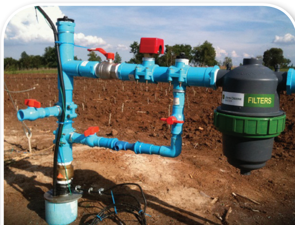
ภาพที่ 43 การติดตั้งกรองเกษตรแบบแผ่น และไล้กรองแบบแผ่นสีแดงความละเอียด 120 Mesh
