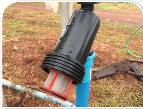
ภาพที่ 41 กรองเกษตรแบบตะแกรง ไล้กรองสีแดงความละเอียด 120 Mesh
