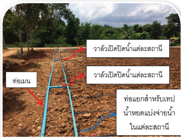
ภาพที่ 65 ตัวอย่างการแบ่งสถานีจ่ายน้ำในแต่ละโซนของพื้นที่ให้น้ำ
