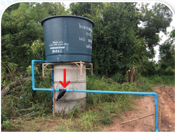
ภาพที่ 44 การติดตั้งกรองเกษตรกับระบบสวนเดร้งน้ำหยด
