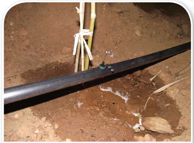
ภาพที่ 39 หัวน้ำหยดแบบกระดุมติดตั้งบนท่อพีอี
