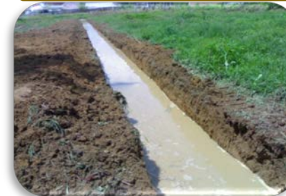
ทำทางระบายน้ำ
