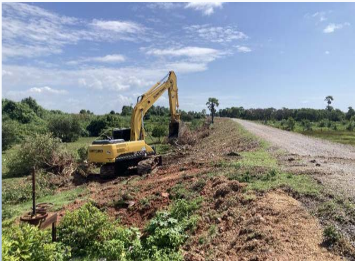
งานทางป่าและงานขุดขยายคันกันน้ำ
