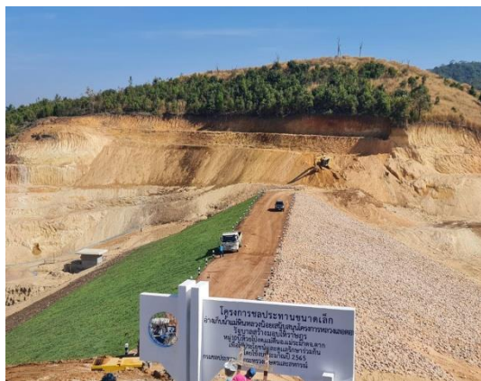
ปลูกหญ้าด้านลาดท้าย แล้วเสร็จ
