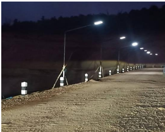
ติดตั้งเสาไฟฟ้าบนสันทำนบอ่าง แล้วเสร็จ
