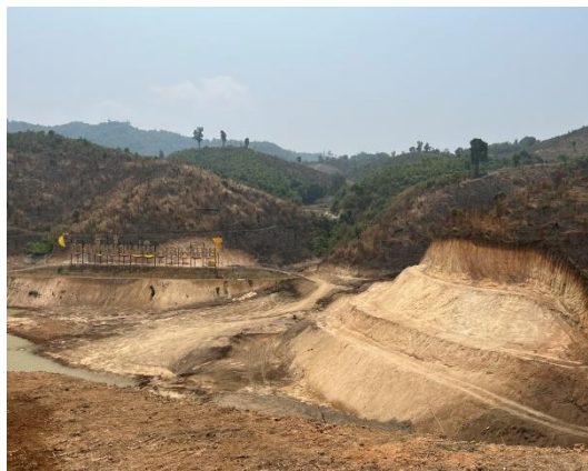
ตกแต่ง Slope ลาดไหล่เขา แล้วเสร็จ
