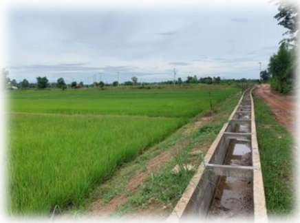
เพิ่มประสิทธิภาพระบบกระจายน้ำ อ่างเก็บน้ำกุดลิงจ้อ
