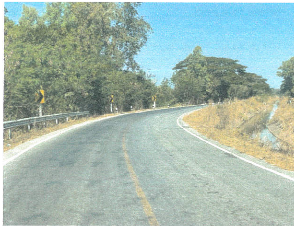
กม. 11+090 (จุดสิ้นสุดโครงการ ตอนที่.4)
