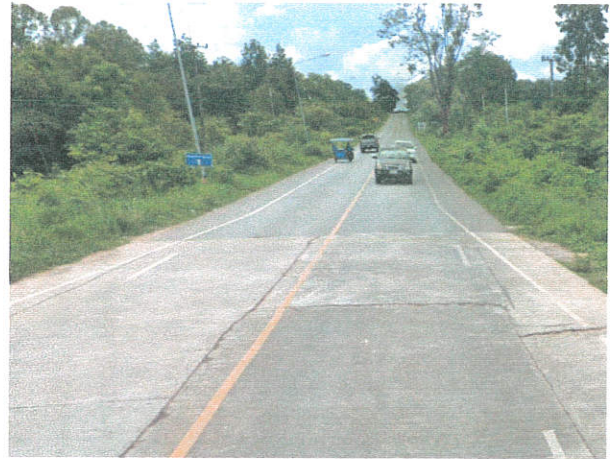
กม. 0+150 (จุดสิ้นสุดโครงการ ตอนที่.1)
