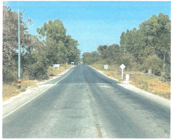
กม. 2+990 (จุดสิ้นสุดโครงการ ตอนที่.2)
