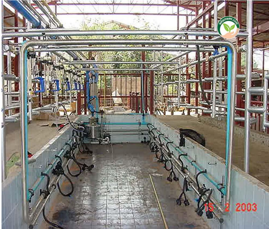
ภาพที่ 2 แสดงระบบรดน้ำแบบหลุม Low Line
