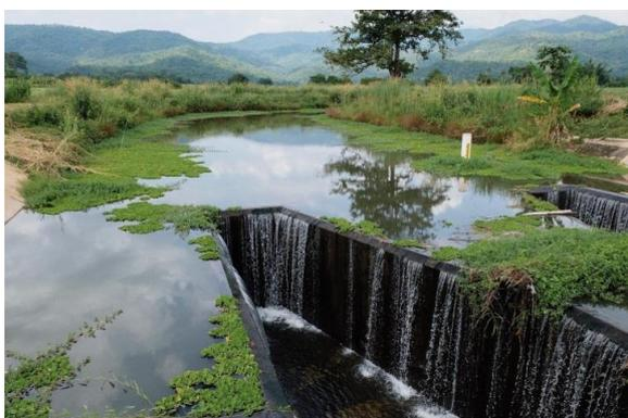
◆ ฝายกั้นน้ำปางสวรรค์ ตั้งอยู่ที่บ้านปางสวรรค์ ตำบลคอกควาย อำเภอบ้านไร่ จังหวัดอุทัยธานี เป็นฝายกั้นน้ำของชุมชนที่สร้างขึ้นเพื่อกักเก็บน้ำและชะลอการไหลของน้ำ ซึ่งหากน้ำมีปริมาณมากเกินไปความจุของฝาย น้ำก็จะไหลล้นข้ามสันฝายลงสู่ด้านล่าง เกิดเป็นม่านน้ำที่สวยงาม ตกกระทบยังพื้นด้านล่างที่เป็นช่องสี่เหลี่ยมกลายเป็นภาพที่ดูแปลกตา สำหรับฤดูที่เหมาะสมควรมาเที่ยวในช่วงฤดูฝน
