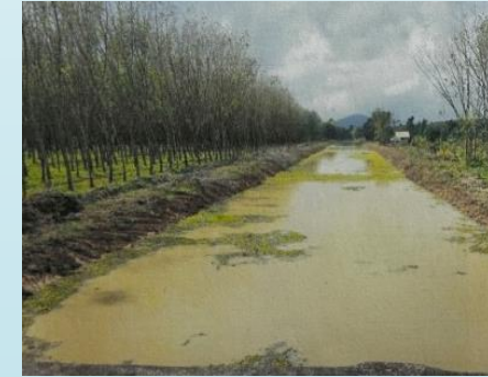
บริเวณ คลองระบายน้ำปึงเหล้งสาย 6
