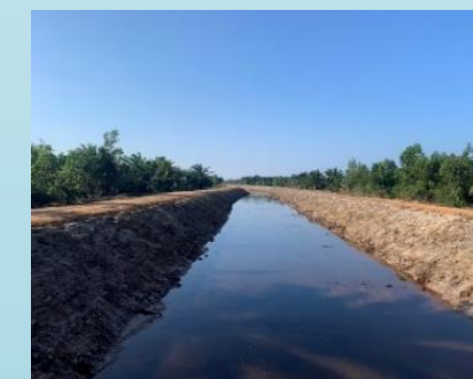
คลองระบายน้ำพูกาบแดงสาย 2
