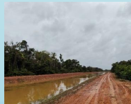
คลองระบายน้ำสาย 6
