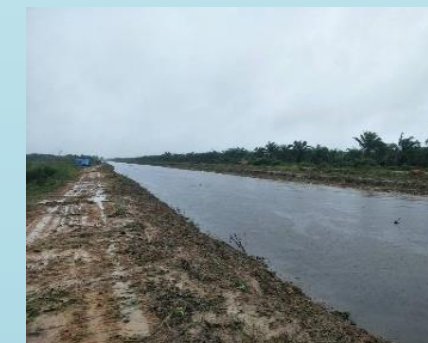
บริเวณ คลองระบายน้ำปึงเหล้งสาย 4
