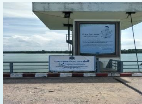
ประตูระบายน้ำบางนราตอนบน ต.กะลุวอเหนือ อ.เมือง จ.นราธิวาส
