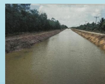
บริเวณ คลองระบายน้ำปึงเหล้งสาย 5
