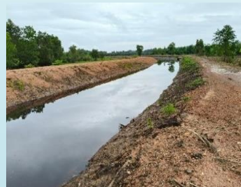
ขุดลอกคลองระบายน้ำ ร 1 ซ้าย สาย 13
