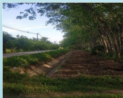
รางระบายน้ำภายในฟาร์มตัวอย่างฯ บ้านตอหลังอันเนื่องมาจากพระราชดำริ
