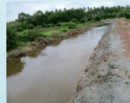
คลองระบายน้ำศาลาใหม่สายที่ 1 และสายที่ 2
