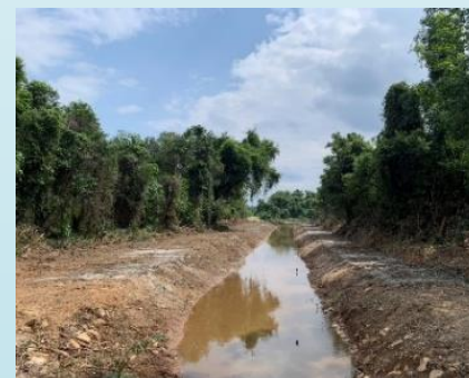
ขุดลอกคลองระบายน้ำพูกาบแดง สายใหญ่ที่ 1
