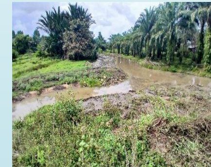
สถานีสูบน้ำบ้านกัวลิตะ(เก่า)
