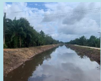
คลองระบายน้ำบางเตย ต.บางขุนทอง อ.ตากใบ จ.นราธิวาส
