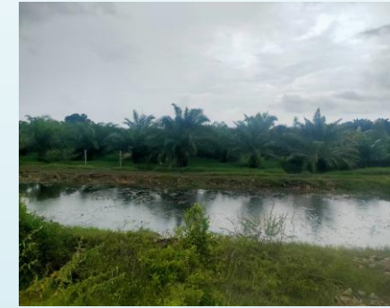
สถานีสูบน้ำบ้านนาคอบิบู(ใหม่)
