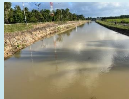
ขุดลอกคลองระบายน้ำ ไต่แดง-ศรีพจน์
