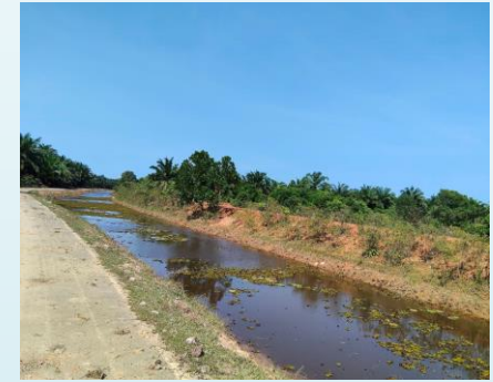
สถานีสูบน้ำบ้านโคกมือบา
